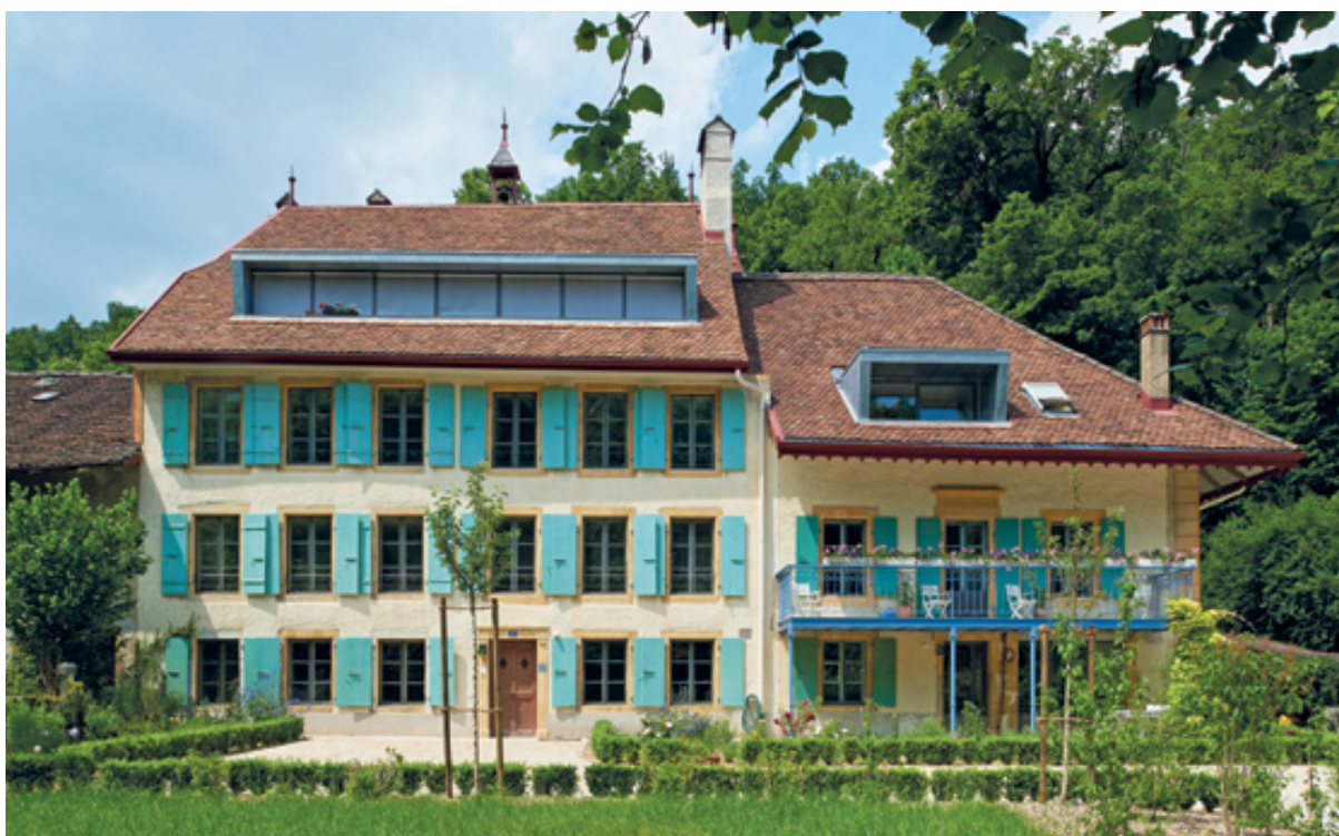
Ce bâtiment protégé a été le premier à être labellisé Minergie-Eco de Suisse romande en 2014. Lutz Architectes:Corinne Cuendet, Clarens
