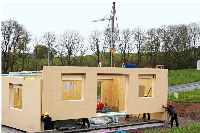
Les éléments sont acheminés par camion et leur mise en place nécessite souvent une grue. Adobe Stock
