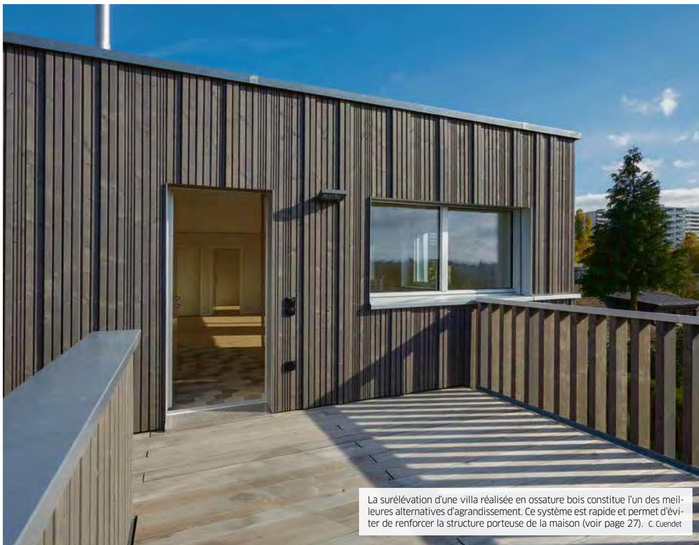
La surélévation d'une villa réalisée en ossature bois constitue l'un des meilleures alternatives d'agrandissement. Ce système est rapide et permet d'éviter de renforcer la structure porteuse de la maison (voir page 27). C. Cuendet
