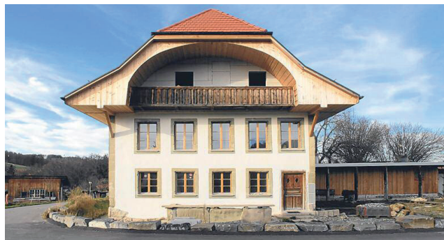
La maison de la famille Reber a désormais le label Minergie-rénovation.
