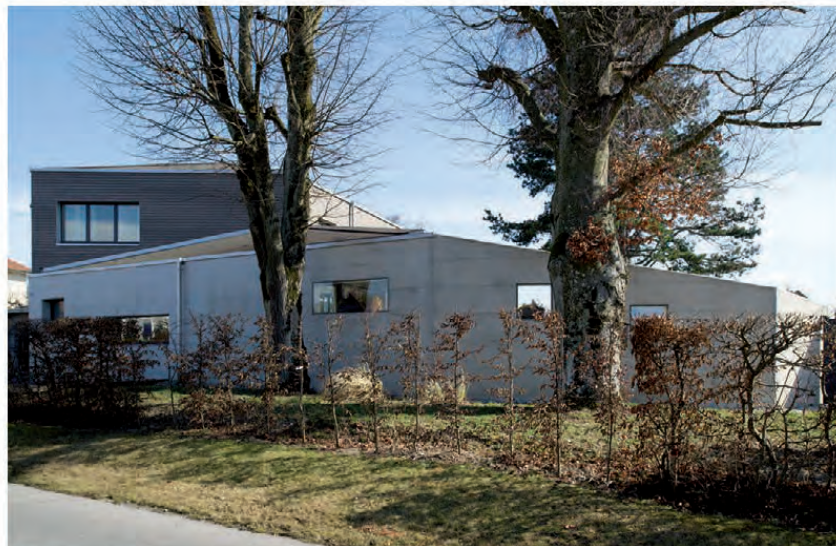
Vue depuis la route, les arbres procurent un abri supplémentaire lorsqu'ils fleurissent.
