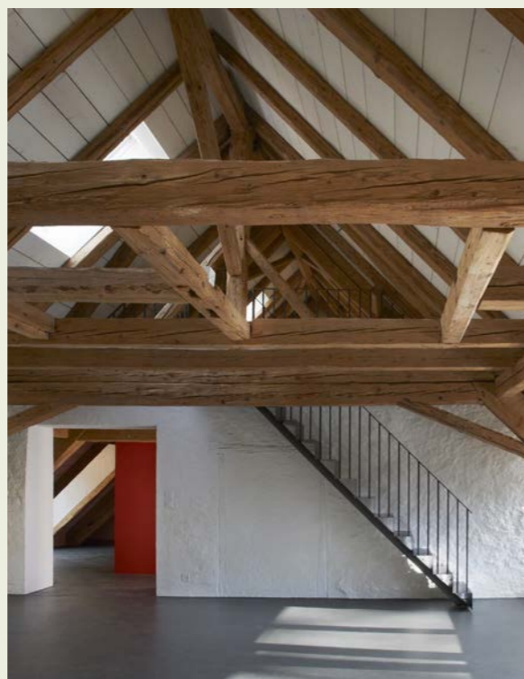
La charpente de 1740, conservée et mise en valeur. La trémie et les chevrons interrompus correspondent à l'emplacement d'un ancien «dôme» servant au chargement par le toit de produits agricoles.
