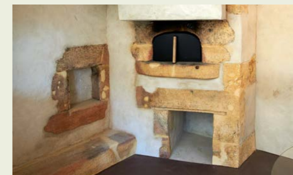
L'ancienne chaufferie au rez cachait un four à pain historique, restauré et remis en fonction à l'occasion des travaux.
