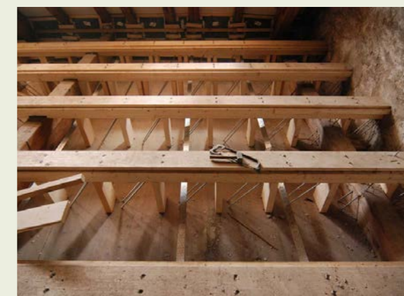
Renforcement du plancher des combles au moyen d'assemblages bois-métal vissés.
