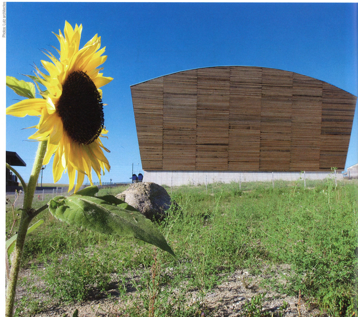
La face sud est entièrement fermée et revêtue de bois. Sa silhouette trapézoïdale à toiture arrondie affirme la vocation de silo de la halle à sel. On aperçoit, ci-contre, le montage des 15 fermes cintrées et des chevrons, avant leur recouvrement par des panneaux OSB, un pare-vapeur et une isolation. Des cassettes en aluminium achèvent la couverture.
