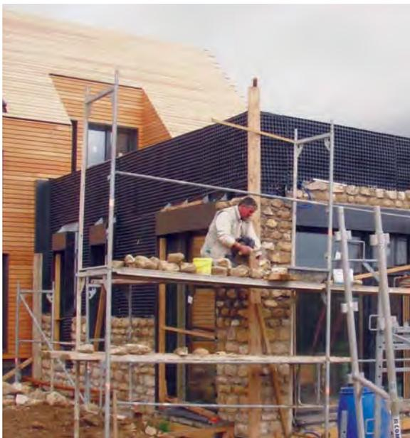
**Photo 8.20** Mise en œuvre de la pierre du Vexin
