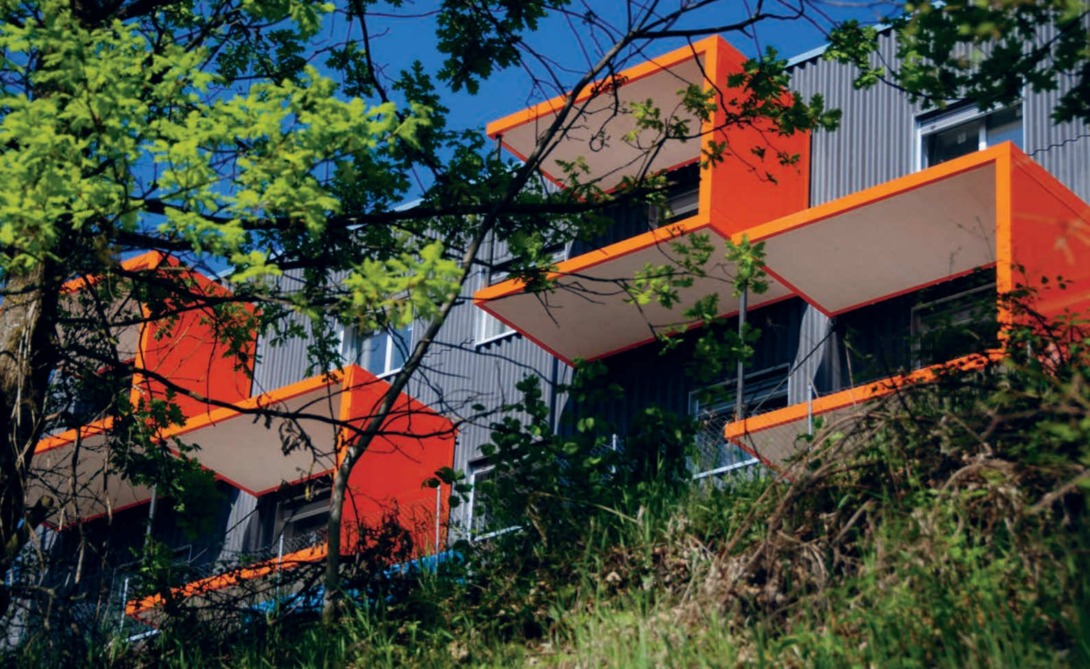
Chantier de Pensier, 2.05.2011
