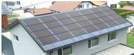
2/3 Avec 10'400 kWh/a, l'installation PV de 8,5 kW en toiture assure une autoproduction de 185%.
